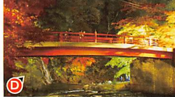
不動橋から見た滝も見どころです
